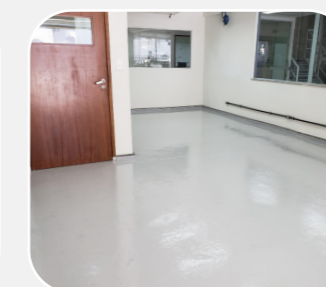
Pintura de piso EPÓXI em Laboratório de faculdade.
